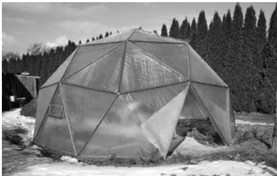
Domen, hvor der dyrkes grøntsager, har brugerene selv bygget
